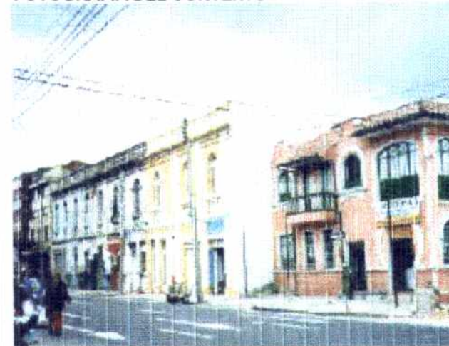
ALTERACIONES A LA EDIFICACION ORIGINAL VISIBLES DESDE EL EXTERIOR :
